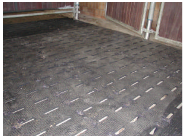
Abb. 5: Frisch mit Gummiauflagen ausgelegte Bucht.
