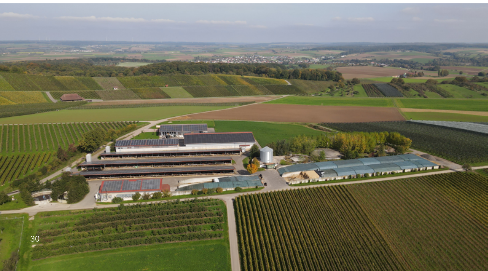
Abbildung 17: Luftbild Biogasanlage Energie Weibler GbR
