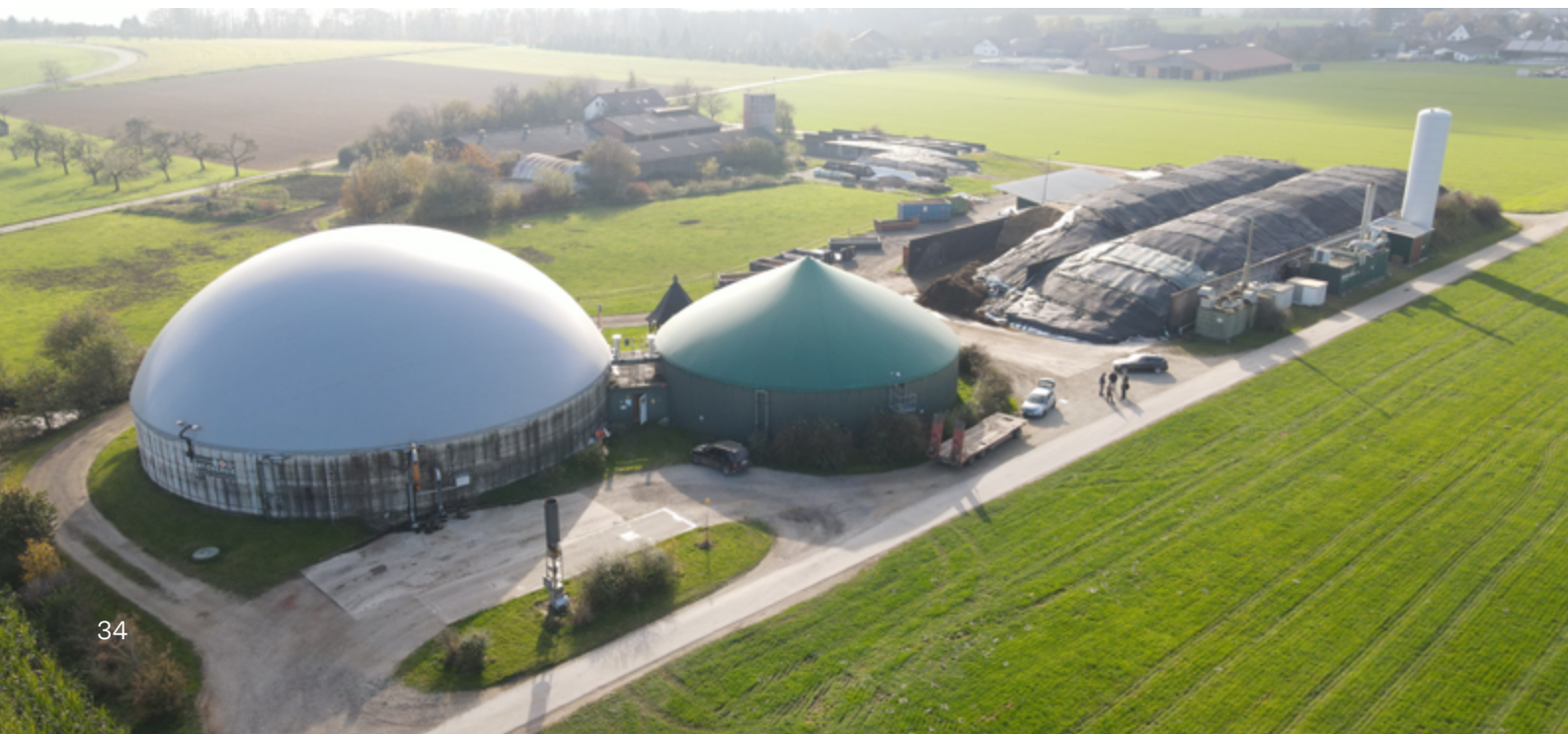
Abbildung 19: Luftbild Biogasanlage Bioenergie Brech GbR
