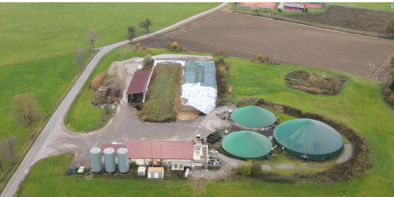
Abbildung 1: Luftbild Biogasanlage Wolfegg
