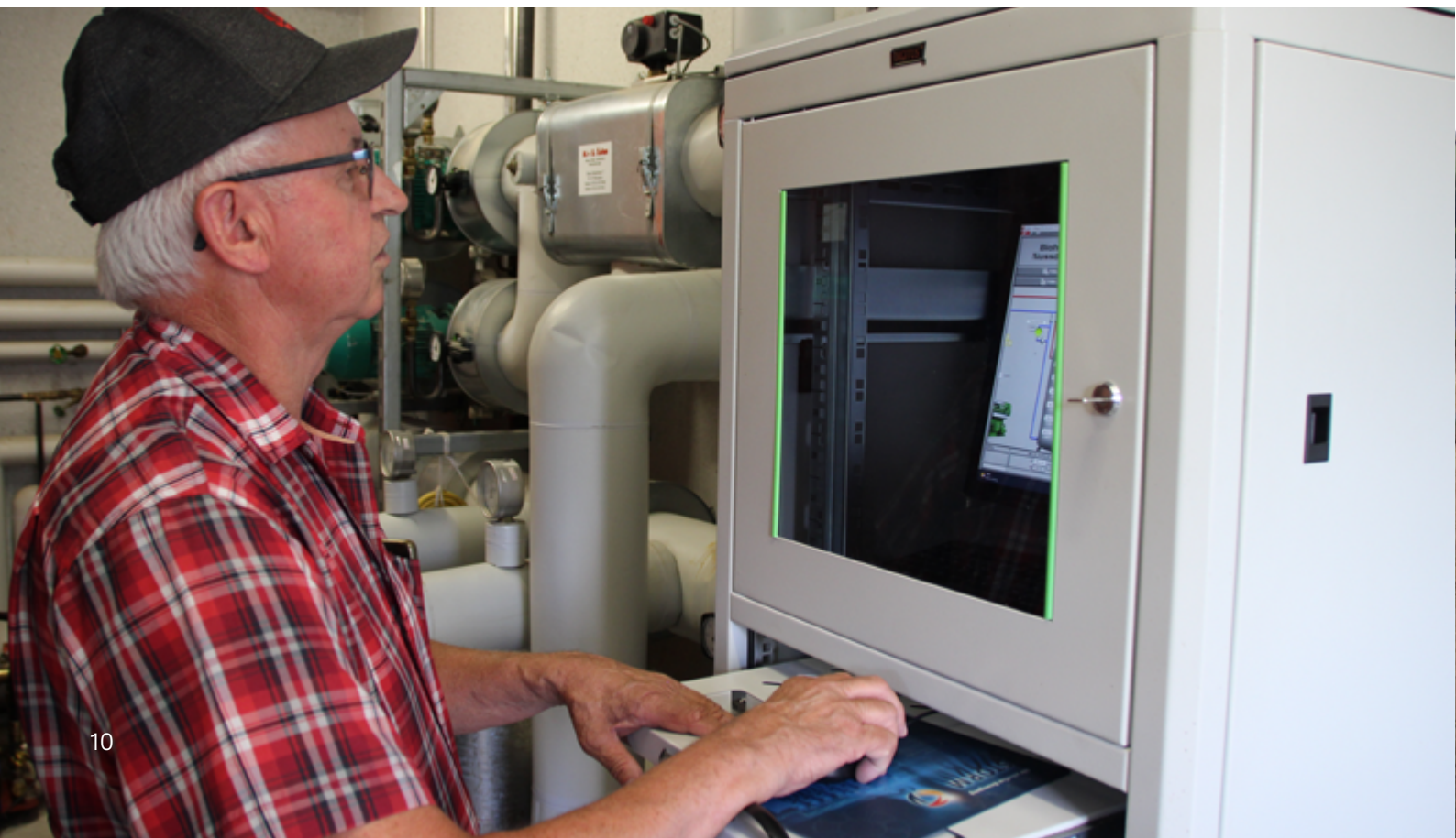
Abbildung 6: Robert Bauz demonstriert die Steuerungstechnik für das Nahwärmenetz
