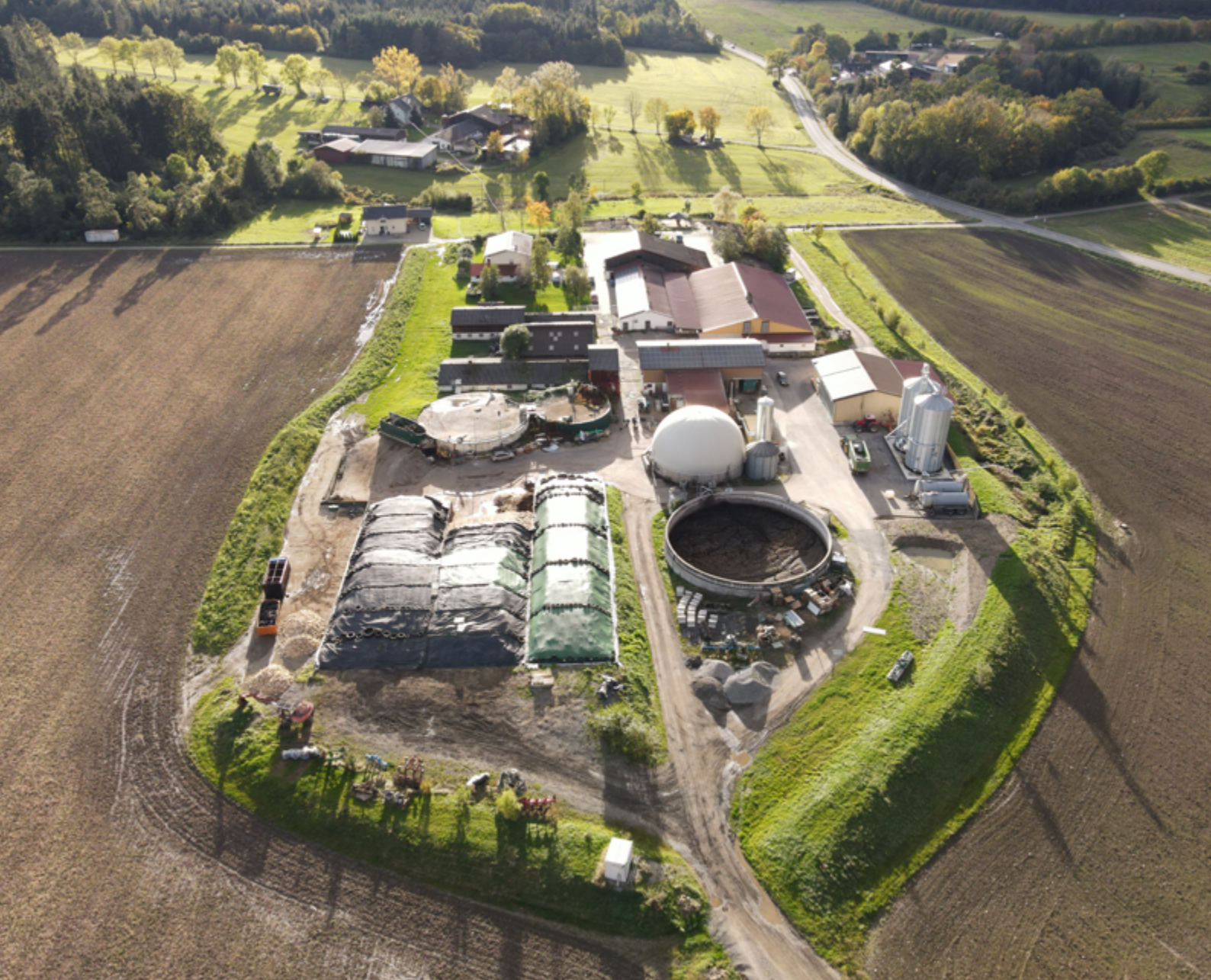
Abbildung 15: Luftbild Biogasanlage Mühlbach GbR
