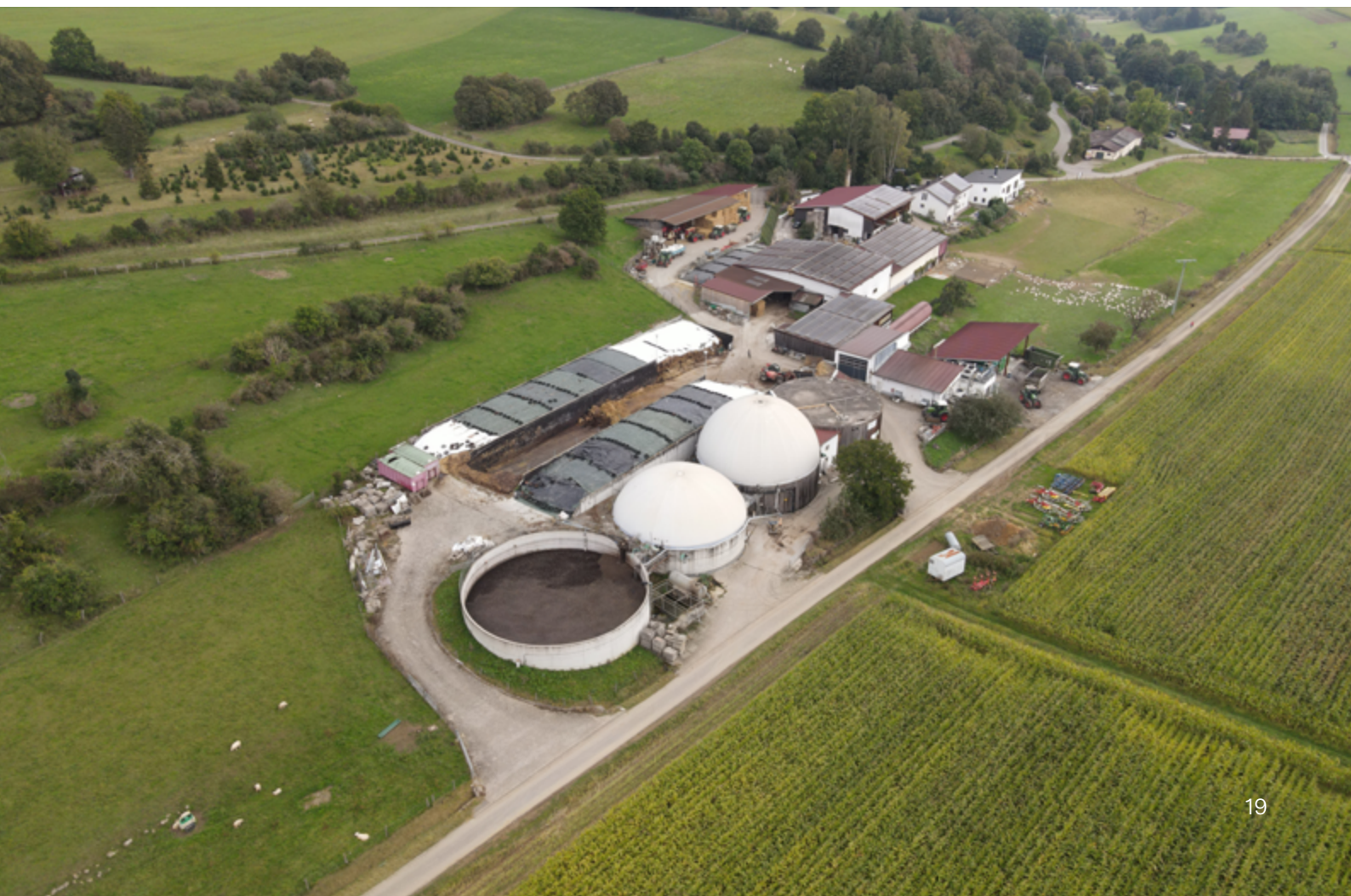
Abbildung 11: Luftbild Biogasanlage Rott Biogas GbR
