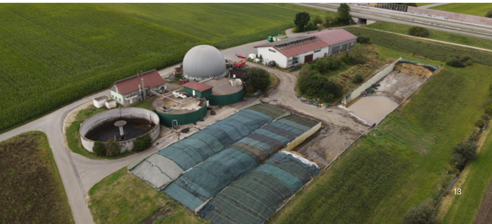
Abbildung 8: Luftbild Biogasanlage Faller Energie
